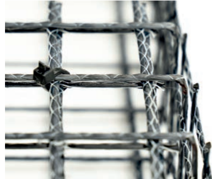
Fügung mit Kabelbinder
